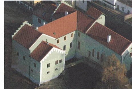
Städtisches Kraftwerk von Písek
