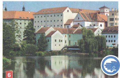
6 MĚSTSKÁ ELEKTRÁRNA – nejstarší funkční vodní elektrárna v Čechách a muzeum. MUNICIPAL POWER STATION – the oldest functioning hydroelectric power plant in Bohemia with a museum. STADTKRAFTWERK – Das älteste funktionsfähige Wasserkraftwerk in Tschechien mit einem Museum. www.elektrarnapisek.cz
